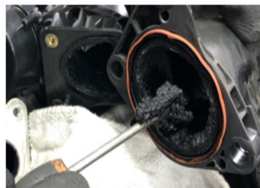
Permeabilidad del sistema limitada por una contaminación con carbonilla excesiva.
