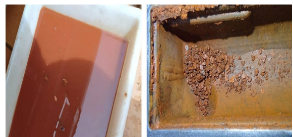
Figuras 4 e 5: Exemplos do uso de água da torneira como líquido refrigerante e a corrosão causada (foto da NRF)
